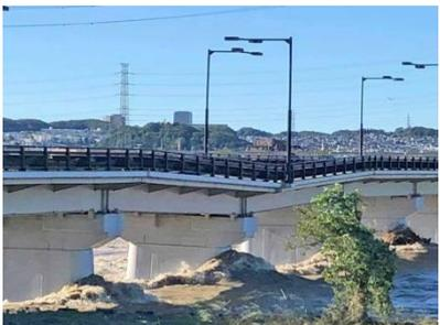
橋脚の沈下(日野橋)
