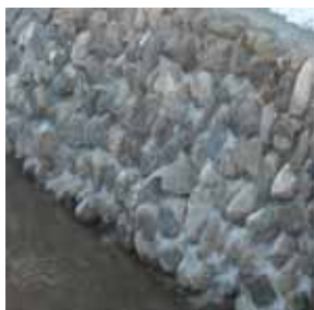
【補強された石積護岸】
