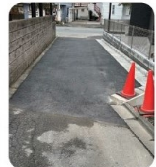
改修された狭あい道路
