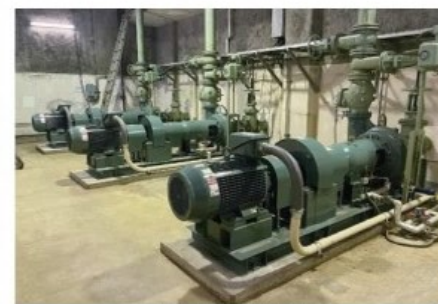
交換された汚水ポンプ
