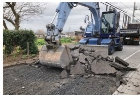
道路の打ち替え舗装工事
