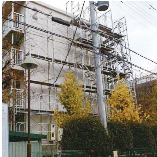
町営住宅の外壁改修工事
