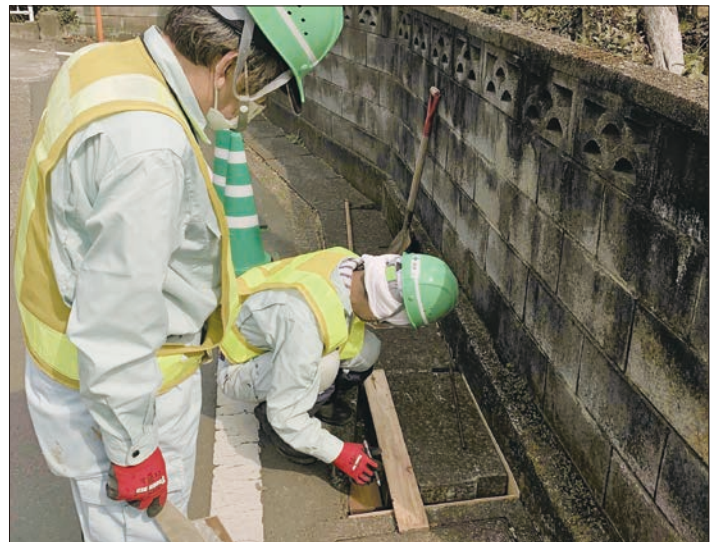
側溝の補修工事 (石畑地区)
