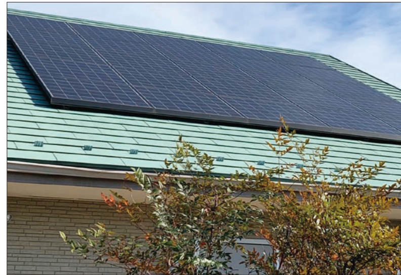
太陽光パネルが設置された住宅
