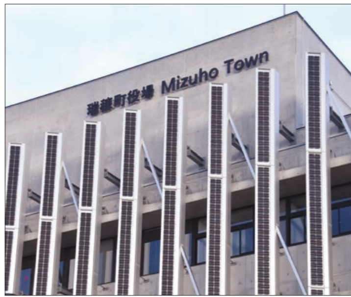
町庁舎外壁のデザインも加味した太陽光発電パネル
