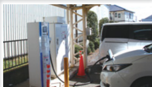
充電中の電気自動車の庁用車 (武蔵村山市)
