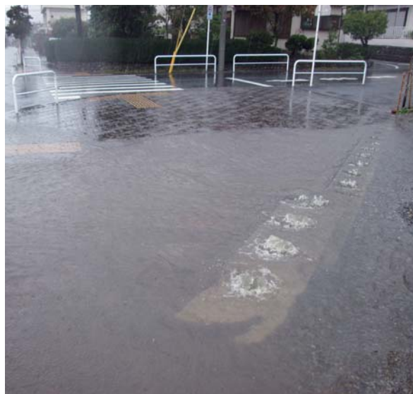
豪雨により道路側溝からあふれる雨水
