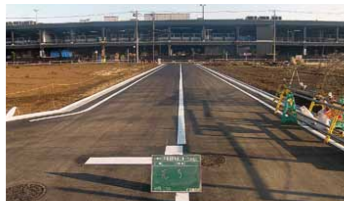
整備を進めている殿ヶ谷土地区画整理事業
