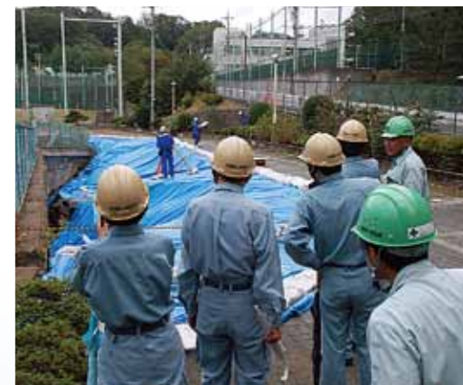
農芸高校正門の崩落現場
