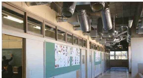
空調工事を行っている二中
