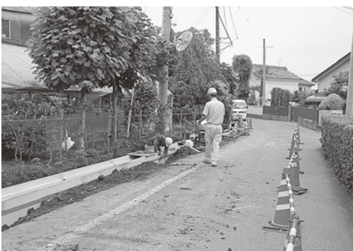
道路拡幅工事（殿ヶ谷地区）
