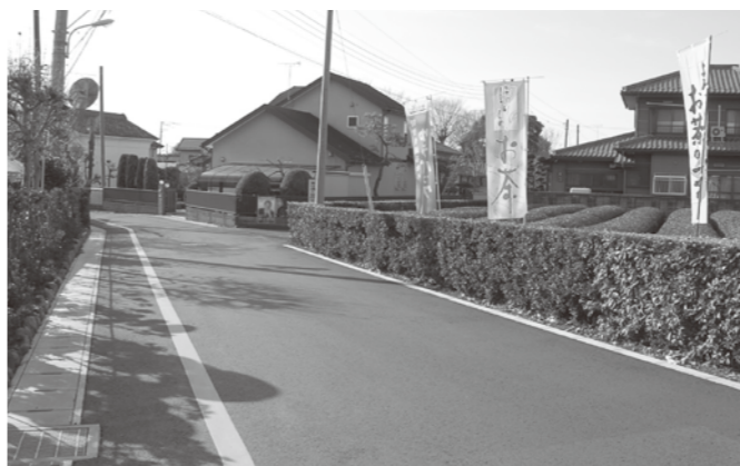
拡幅された町道（殿ヶ谷地区）
