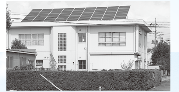
箱根ケ崎南会館に設置された太陽光発電設備（10kw）
