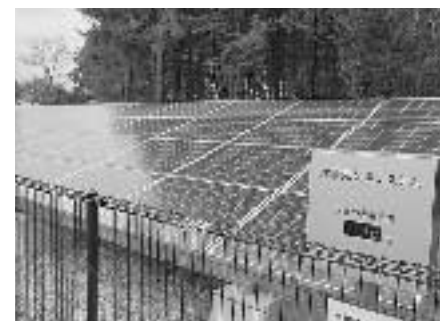
リサイクルプラザの太陽光発電システム
