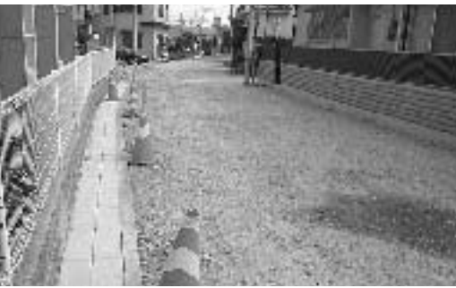
町道25号線の舗装工事（箱根ヶ崎地区）
