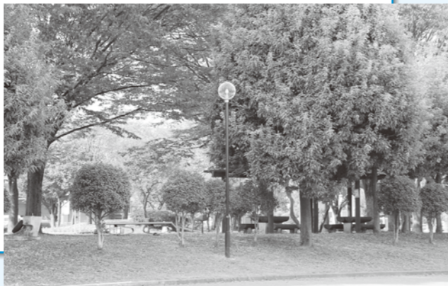
下師岡公園に設置された公園灯
