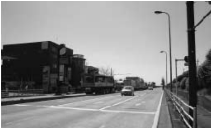
無電柱化されている国道16号（松原中央公園入口交差点付近）
