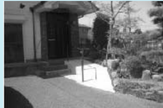
新たに対象となるバリアフリー対応型改修工事
