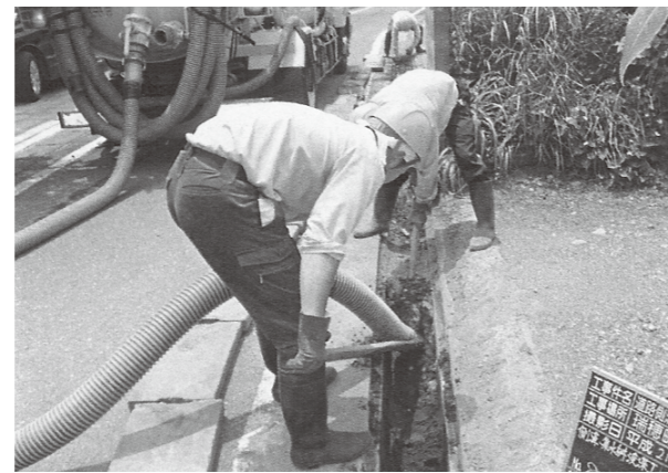
側溝の浚渫作業
