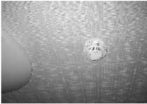
住宅用火災警報器（煙感知）
