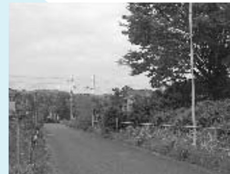
19年度に設置された独立柱式防犯灯(元狭山地区)
