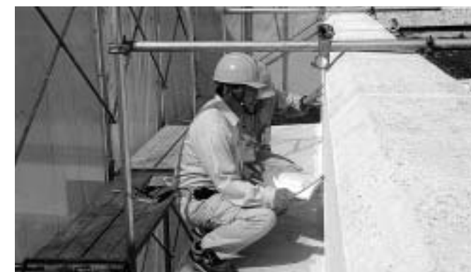
現場を監督する町職員(殿ヶ谷会館)
