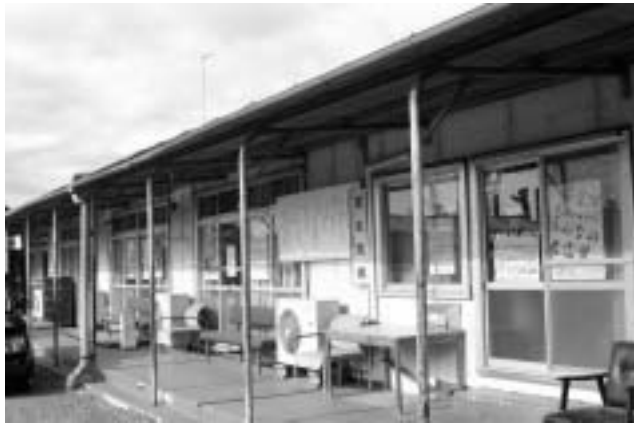
解体する旧シルバー人材センター（役所西側）
