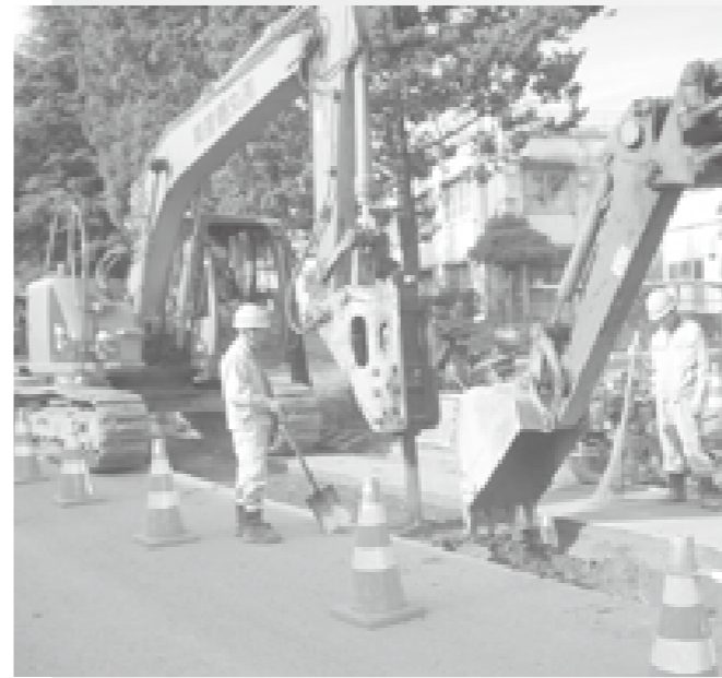
大型ブレイカー等によるセメント処理層の撤去作業
