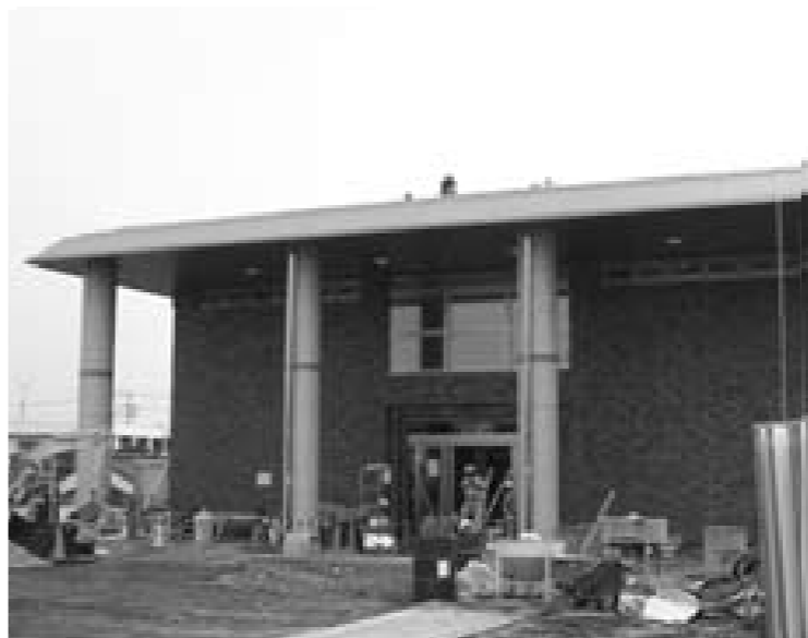
町発注の公共工事(元狭山コミュニティセンター)
