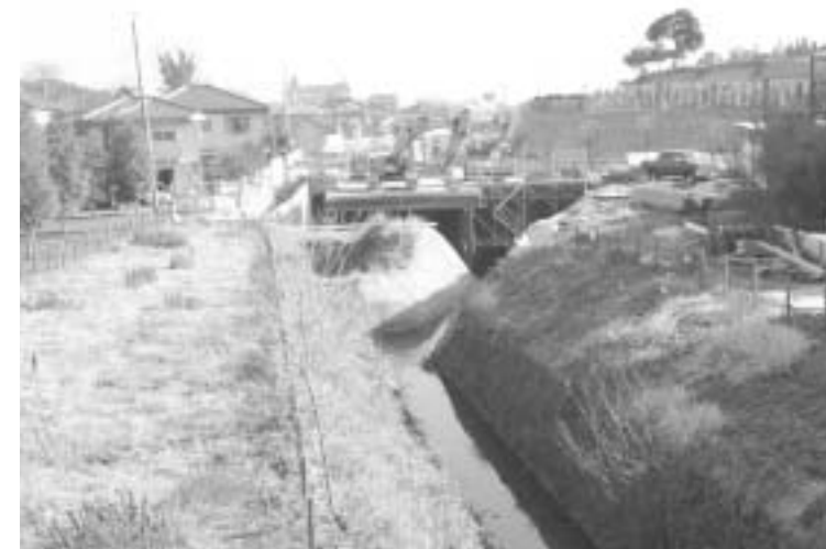
河川改修が進む残堀川
